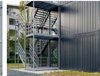
| Stahlausstertreppenturm mit Podesten | Ausstertreppenturm
