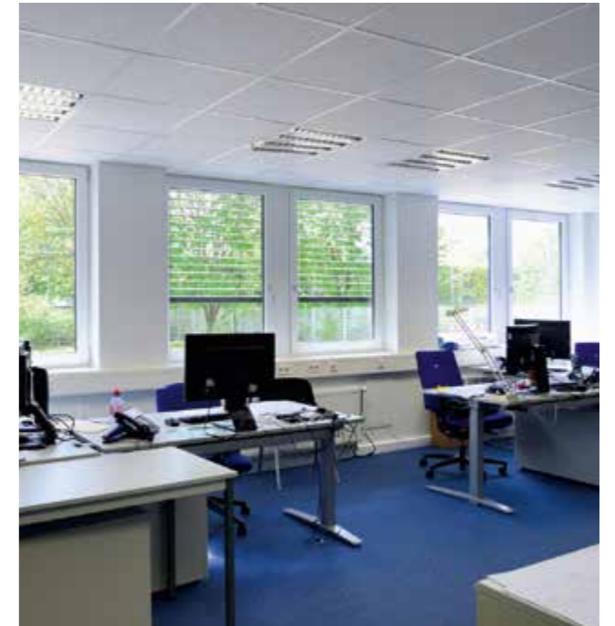
FAGSI konzipierte das technisch hochmoderne Rundum-Paket von der energiesparenden LED-Beleuchtung bis hin zur EDV-Verkabelung.
