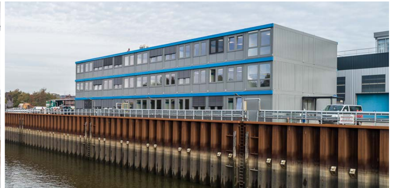
Die Baustelle am Muggenburger Kanal forderte nicht nur erhöhte Sicherheitsauflagen, sondern auch höchste Präzisionsarbeit.
