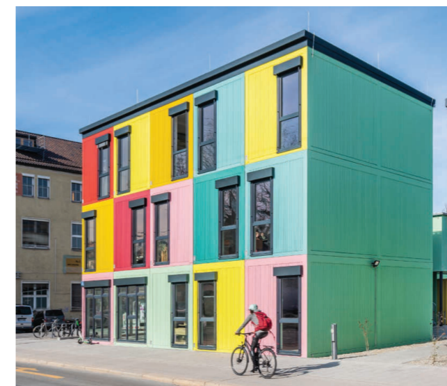
Mit individuellen Grundrissen und der dazu passenden Fassadengestaltung können Planer jedem Anspruch gerecht werden.
