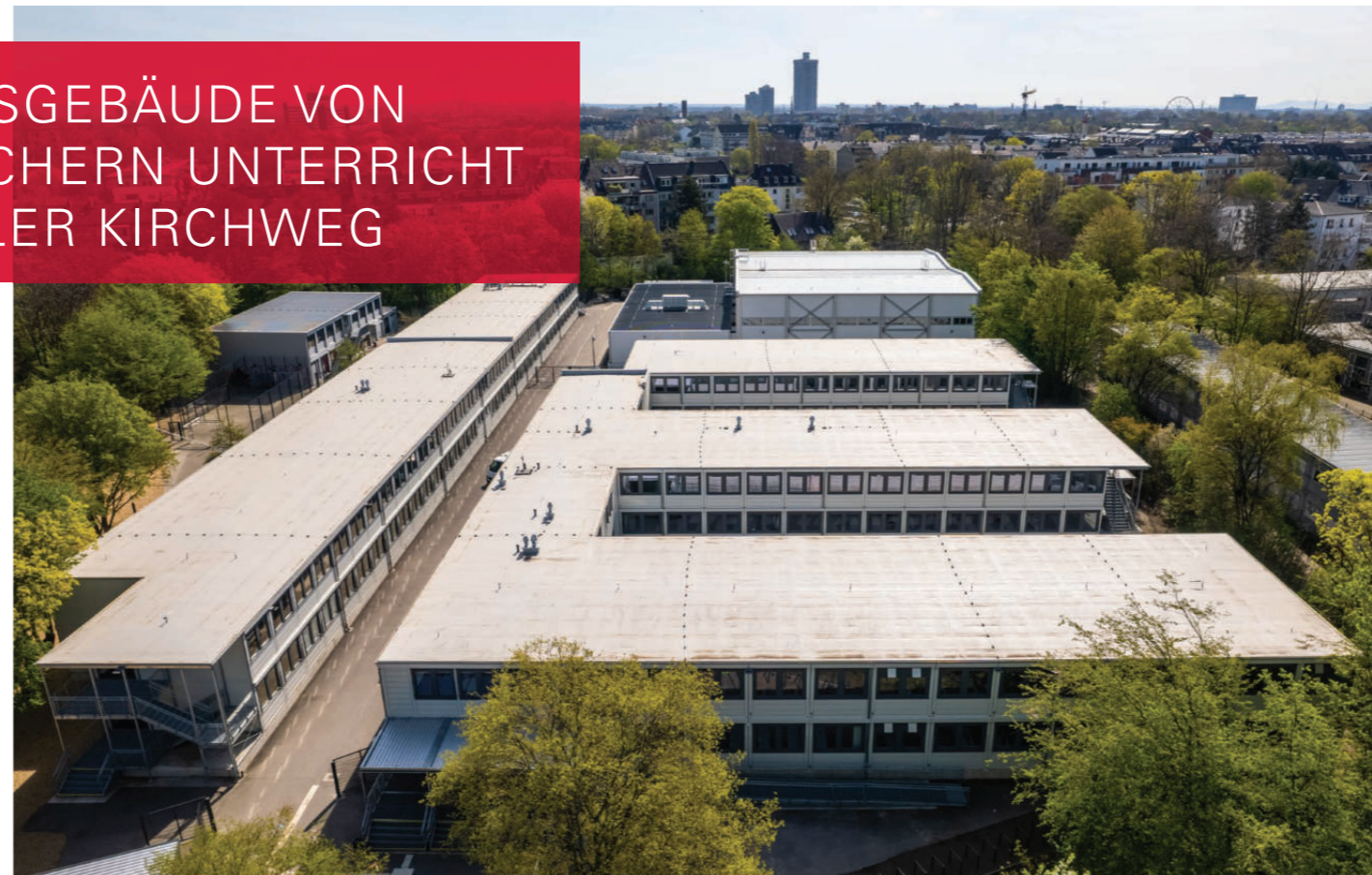
Für das Barbara-von-Sell-Berufskolleg (rechts) entstand ein zweigeschossiges Gebäude mit insgesamt 4.268 Quadratmetern Bruttogrundfläche. Die Edith-Stein-Realschule erhält ein Interimsgebäude mit insgesamt 3.530 Quadratmetern verteilt auf zwei Geschosse. Insgesamt wurden 224 Container geliefert und montiert.
