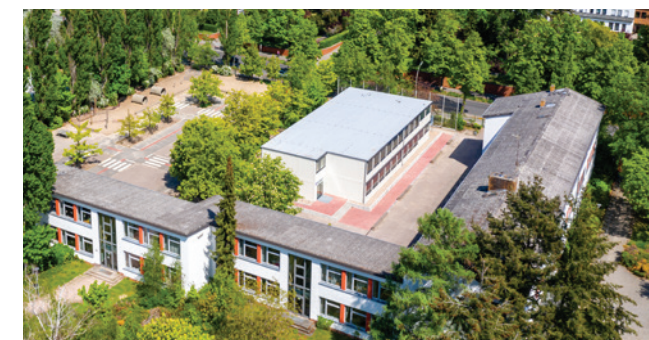
Im Schulhof der Grundschule am Königsgraben in Berlin entstand in nur zwölf Wochen eine zweigeschossige Anlage für rund 240 Kinder.
