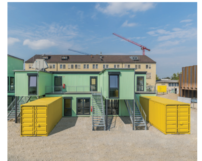
Vor- und zurückspringende sowie auskragende Elemente schaffen eine räumlich abwechslungsreiche Situation zwischen den Containerreihen. Gelbe Hochseecontainer wurden in die Anlage integriert.
